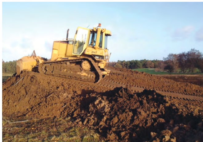
Total omlægning af 3. hul på AGC`s bane. Der blev flyttet over 100 tons jord, så man fra teestedet kunne se ned over hele hullet og op til greenen. Sikkerheden og spillet blev væsentlig forbedret.
