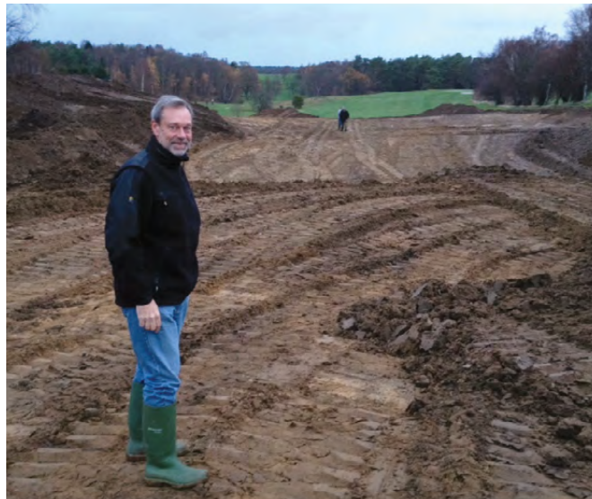
Formand William Grahm var øverste boss for projektet med omlægning af 3. hul på banen. Måske en af de bedste og største omlægninger i nyere tid. William var selv oppe at køre gravemaskinen, og man kan se stoltheden lyse ud af formandens øjne.
